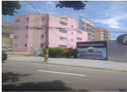
Vistas da fachada do imóvel
