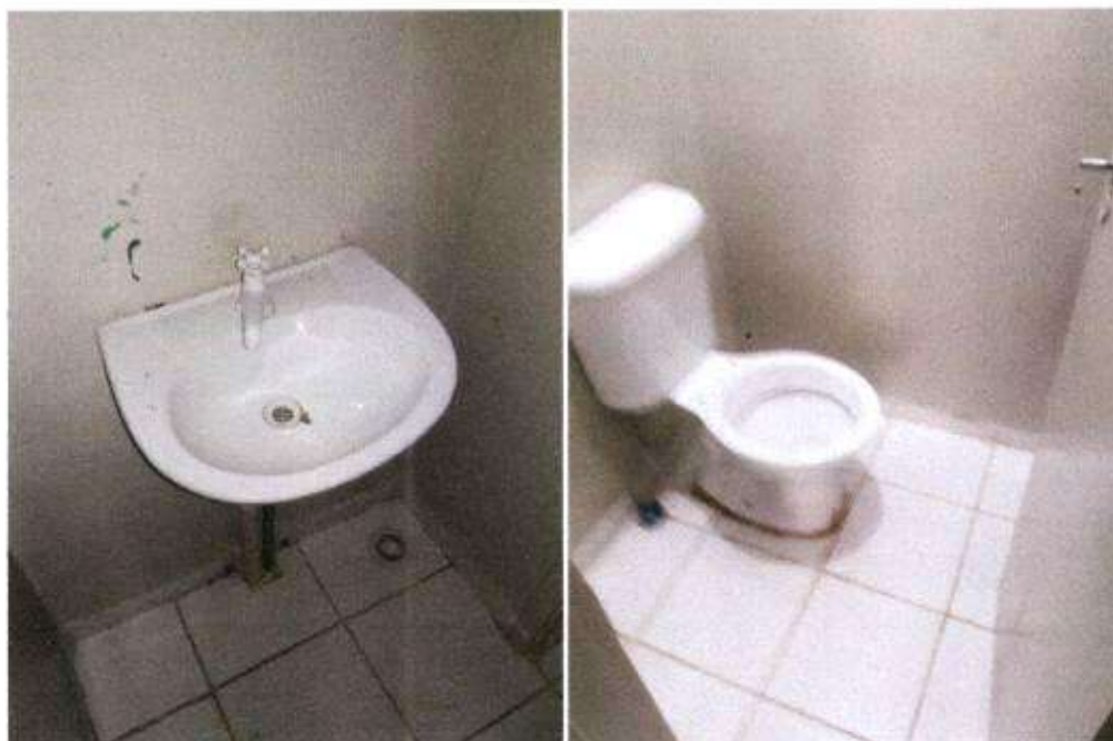
15- Banheiro Salão de eventos
