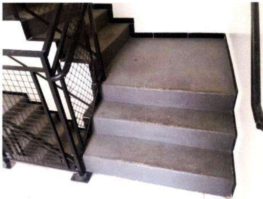
8- Acesso aos pavimentos
