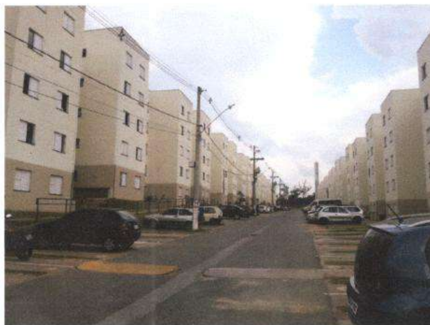
20- Via de acesso às torres
