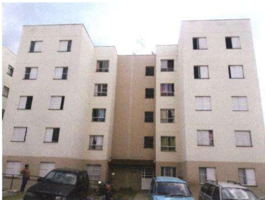
3- Torre 3 – alvo da vistoria
