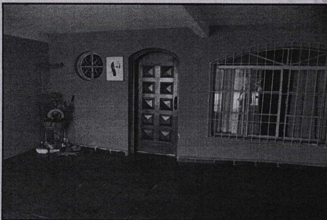
FOTOS 04/05 : Vistas externas da edificação.
