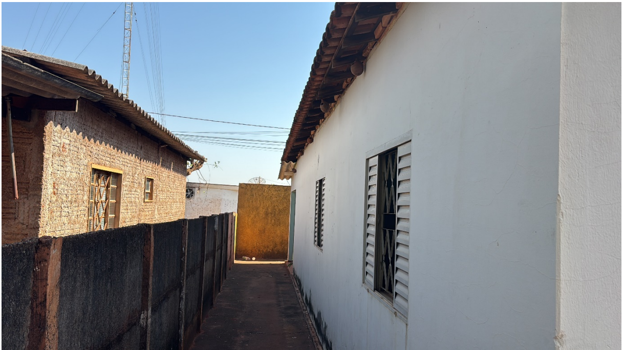
Foto 12: lateral direita do imóvel
