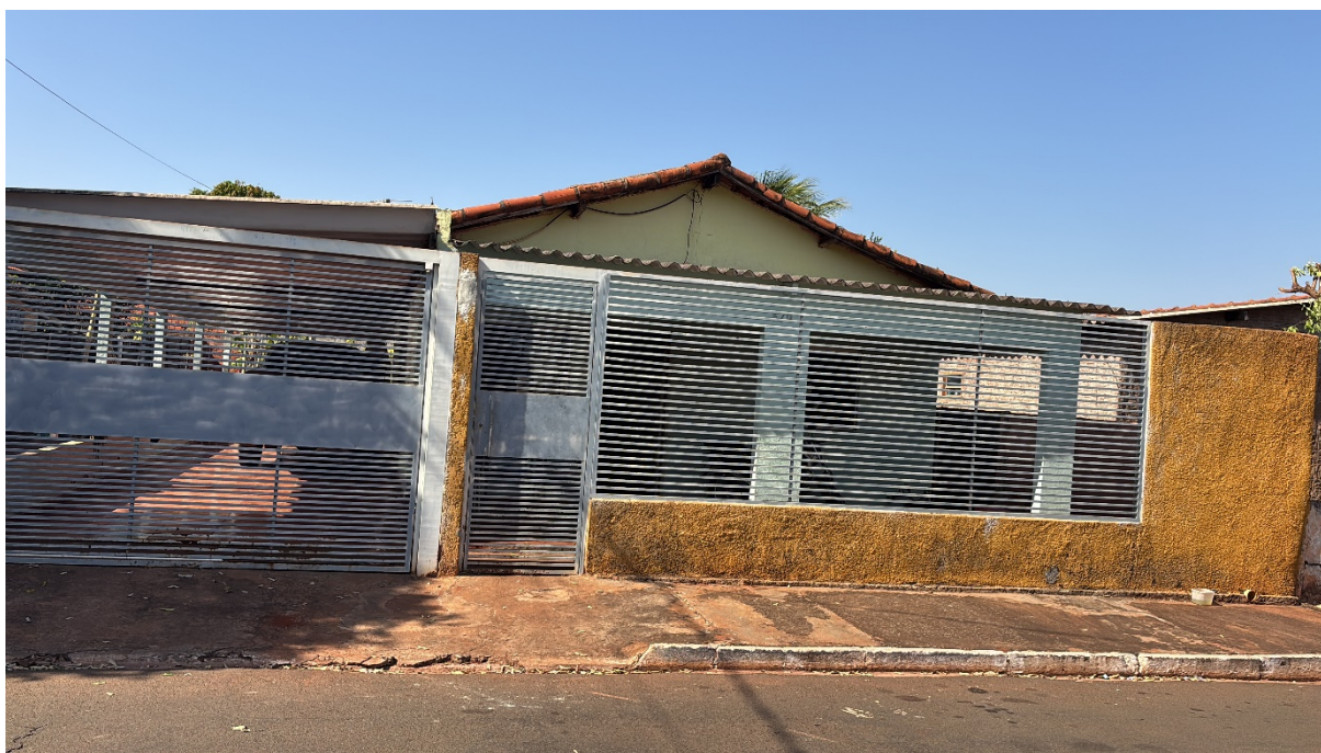
Foto 01: Frente do imóvel
