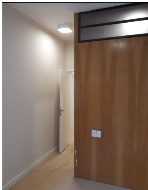
FOTO 26. Vista geral do dormitório.
