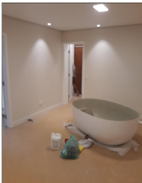
FOTO 21. Vista geral do banheiro social.
