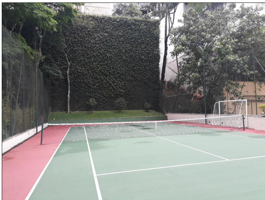
FOTO 3. Vista geral da quadra poliesportiva.
