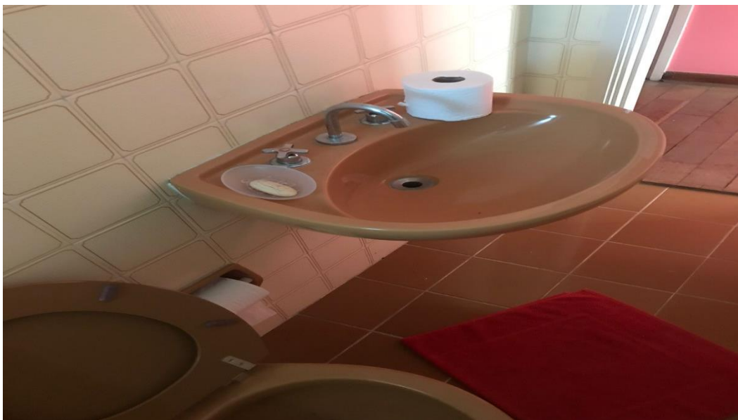
FOTO 16 Vista ampliada para o banheiro da suíte.
