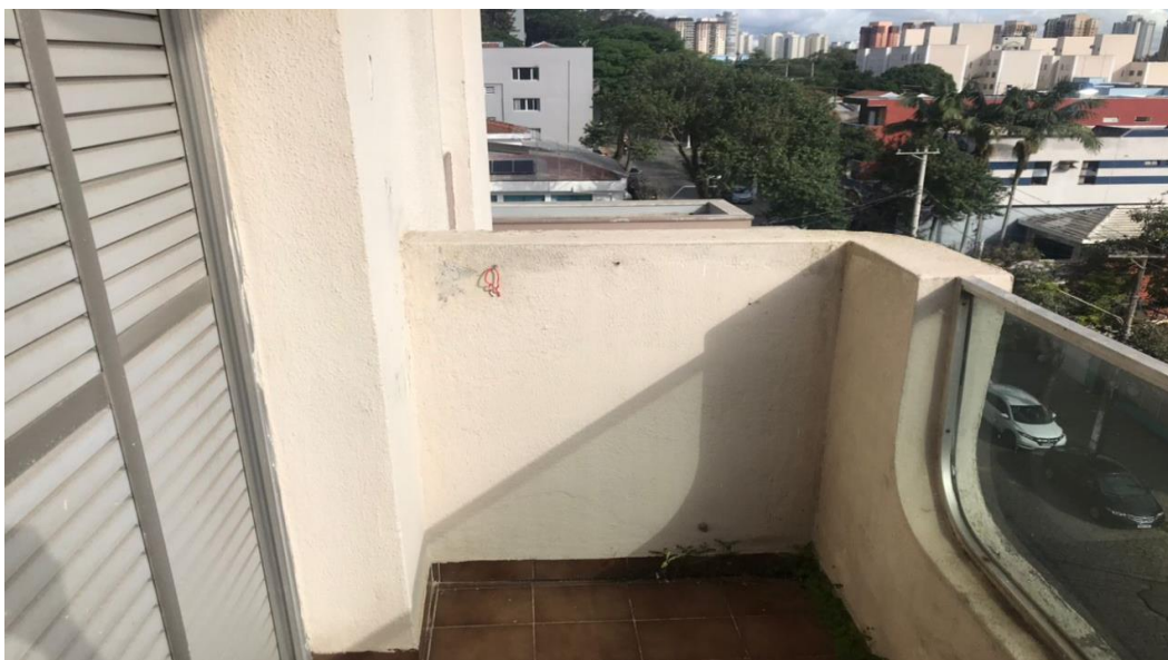
FOTO 8 Vista para a sacada do apartamento.
