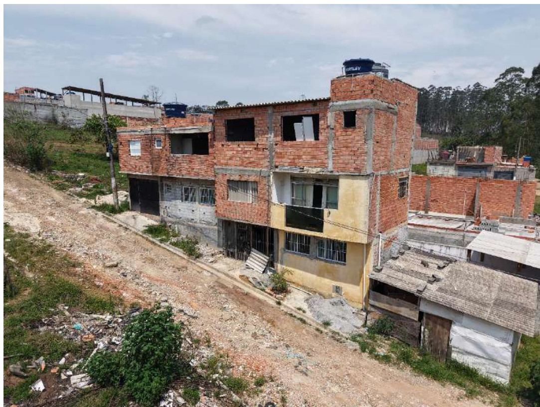
Figura 14 – Exemplo de imóvel inserido dentro do loteamento
