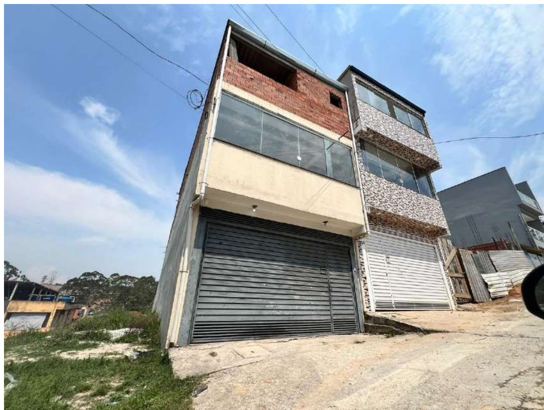
Figura 12 – Exemplo de imóvel inserido dentro do loteamento
