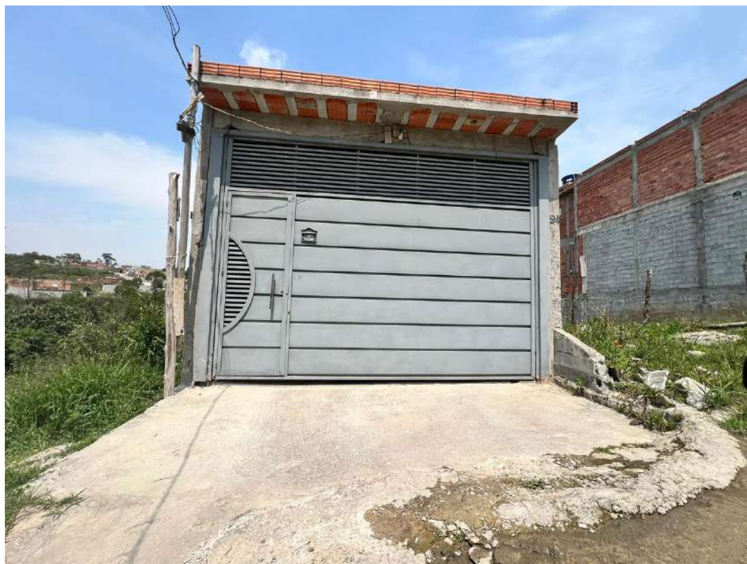
Figura 11 – Exemplo de imóvel inserido dentro do loteamento
