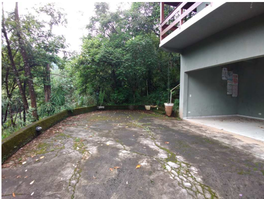
VISTA DA ÁREA EXTERNA.
