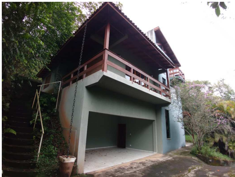
VISTA DAS CONSTRUÇÕES ERGUIDAS SOBRE O TERRENO.
