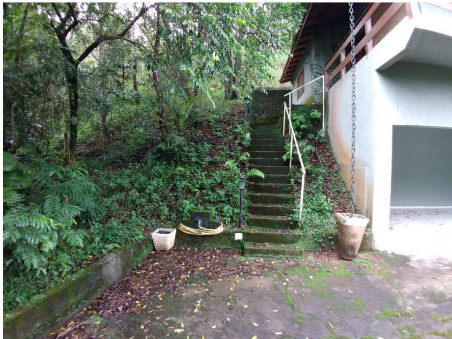
VISTA DA ESCADA DE ACESSO AO QUINTAL.
