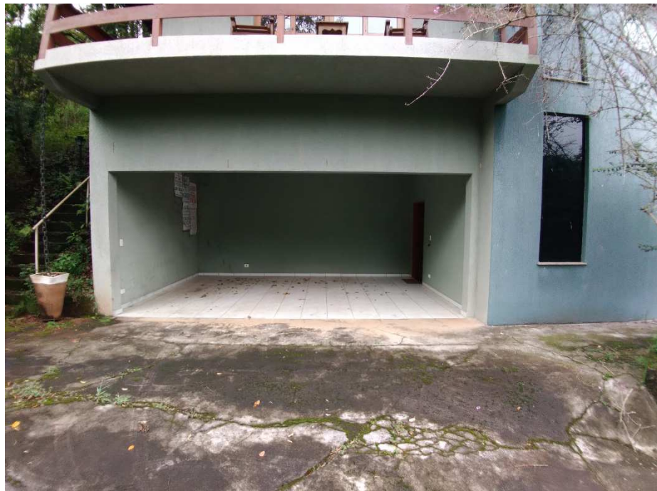
VISTA DA GARAGEM.
