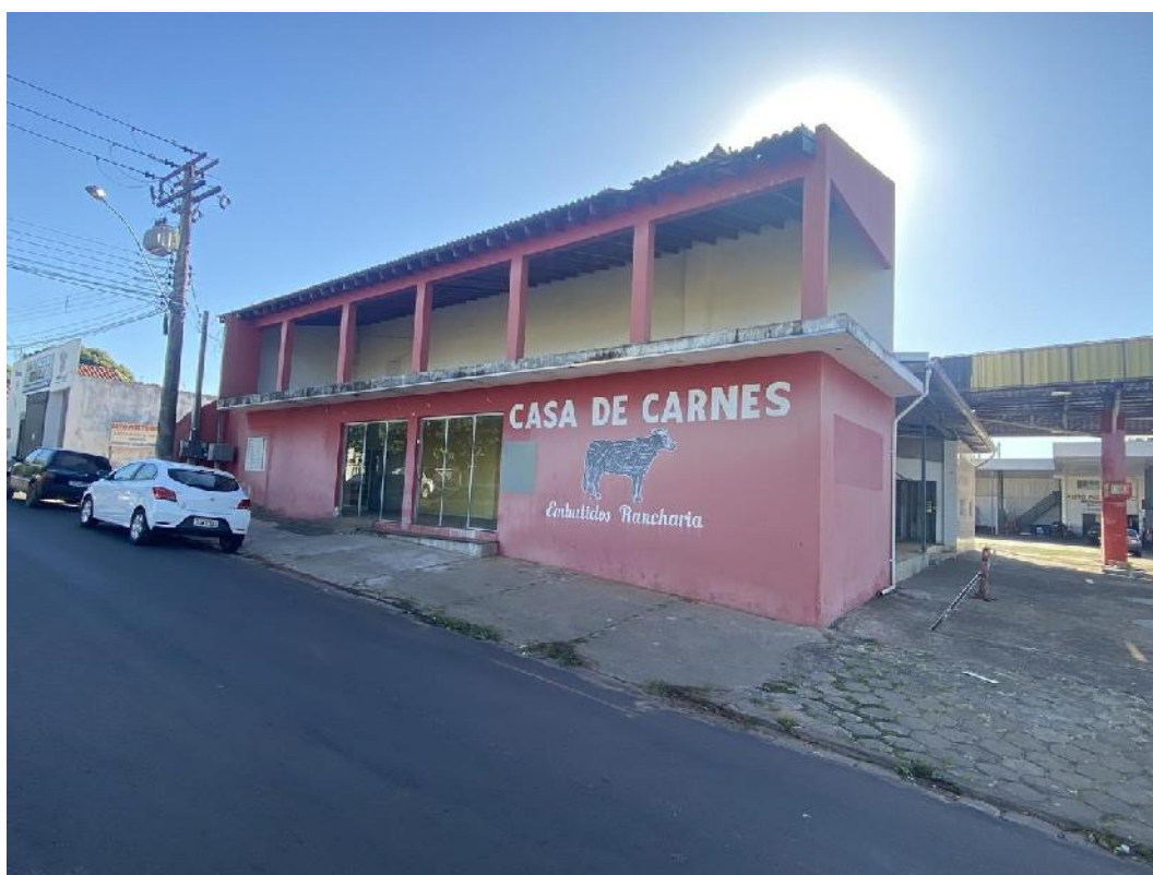
Lateral do imóvel "parte nova"
