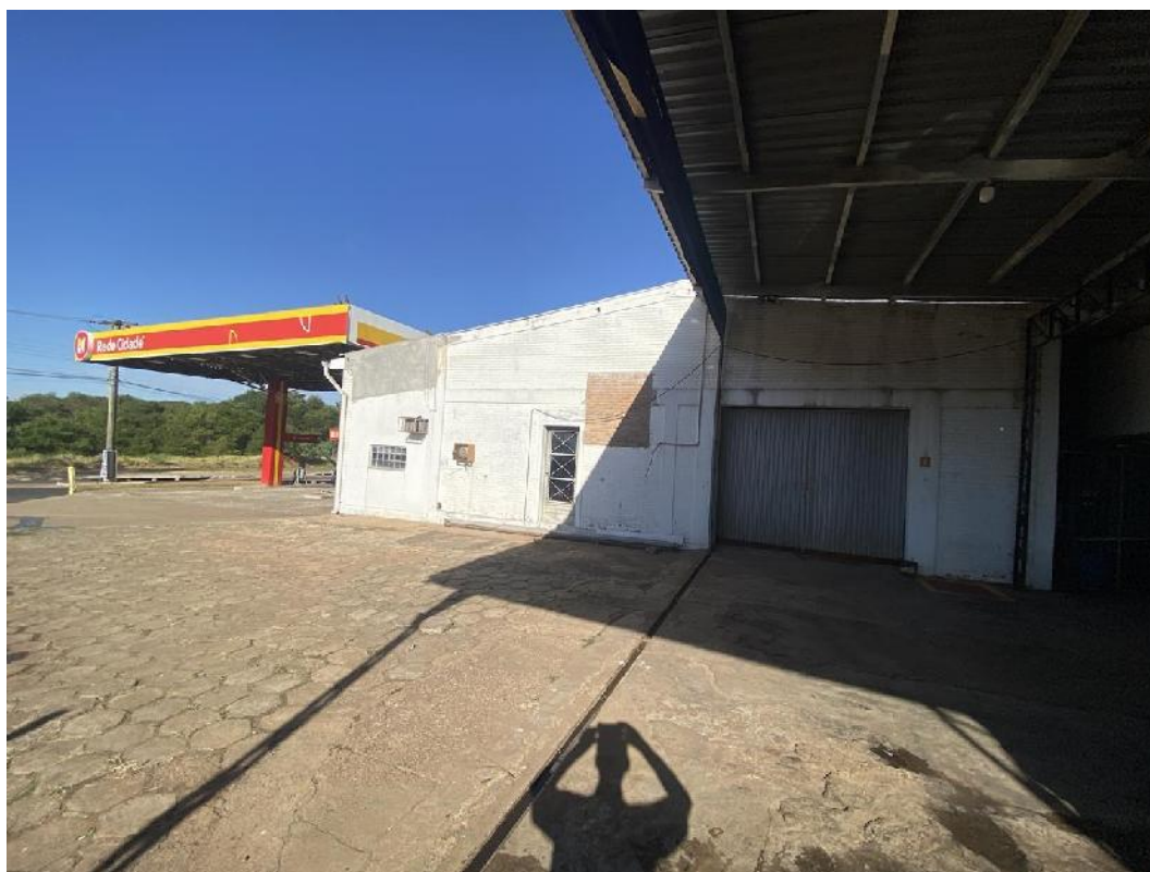
Parte lateral do posto
