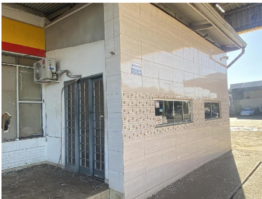
Escritório de atendimento do posto
