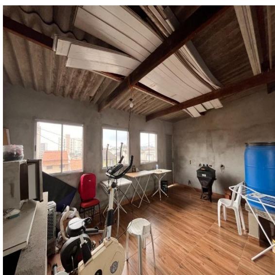
Foto 12: 2º Pavimento: Vista da área de serviço.
