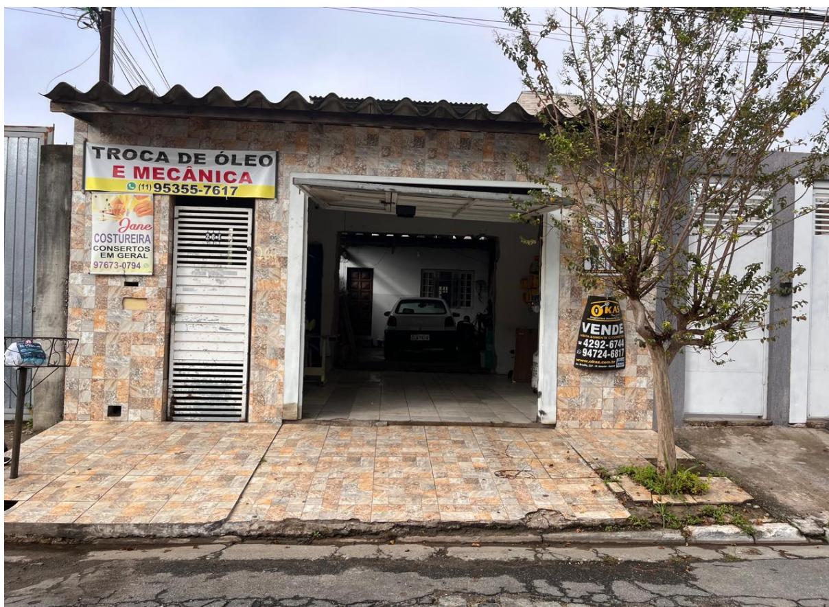
Foto 01: Vista da fachada do imóvel.
