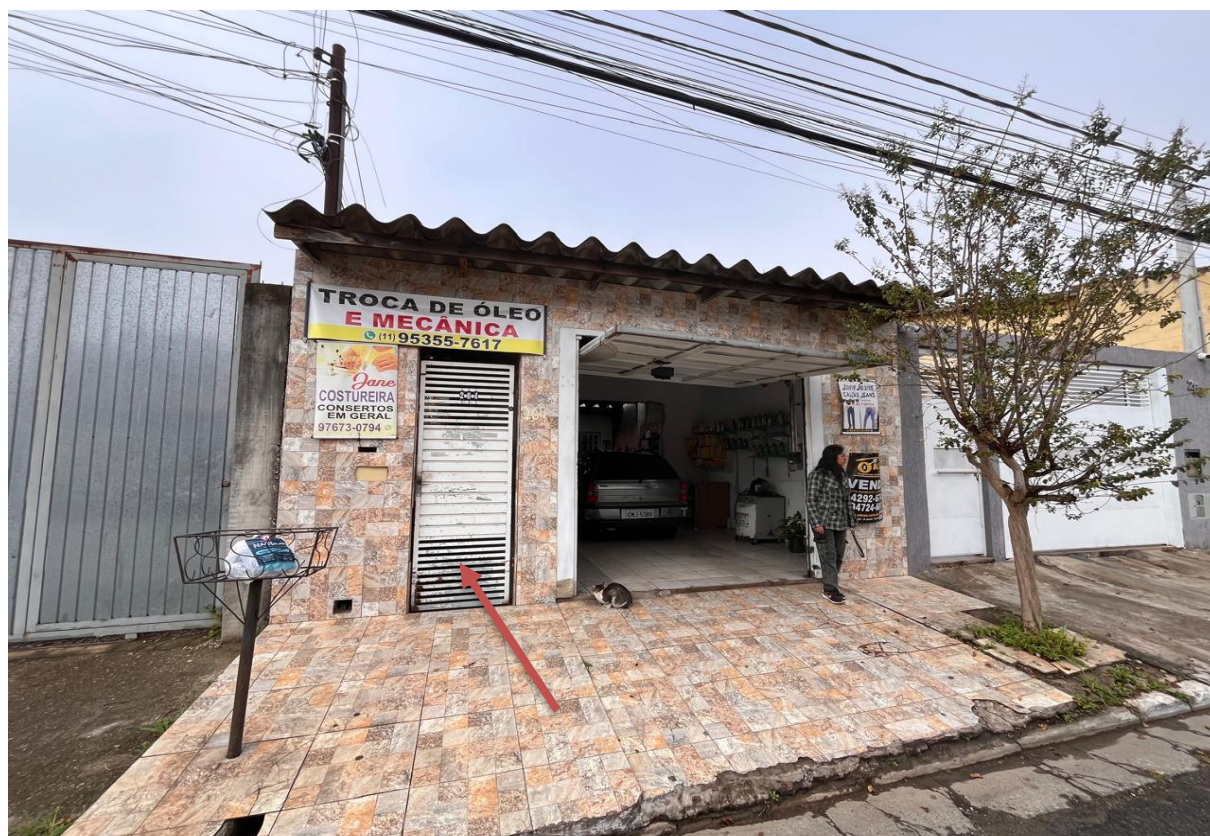
Foto 15: Vista acesso na lateral ao imóveis que estão alugados.
