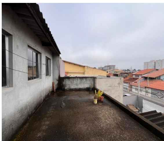
Foto 13: 2º Pavimento: Vista da área externa.
