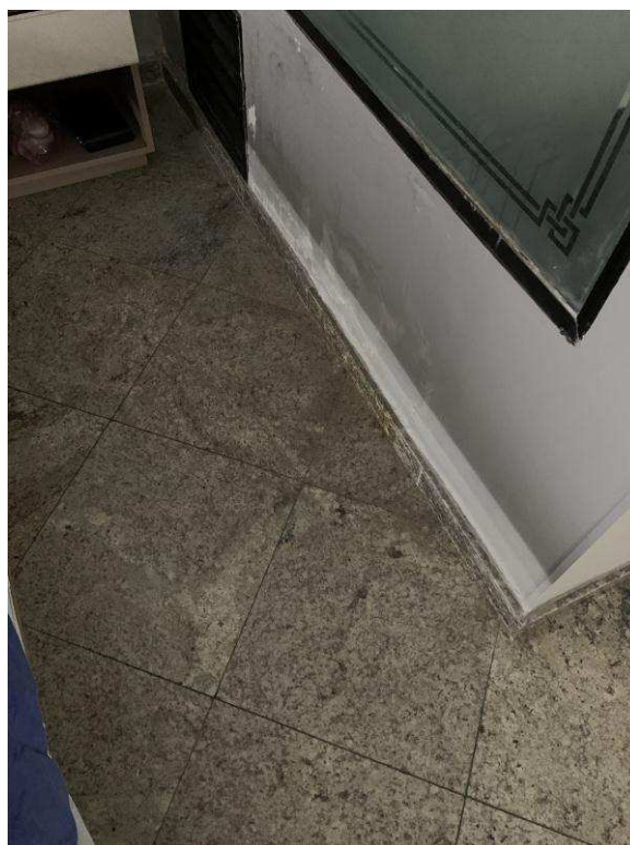
Foto 19: Umidade na parede entre o quarto e o banheiro
