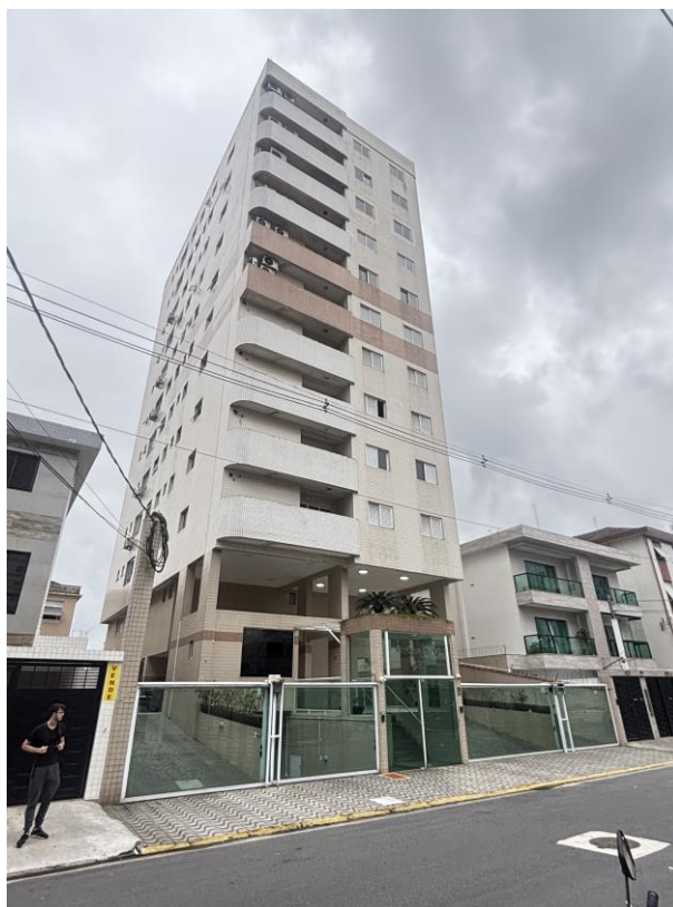
Figura 2: Vista geral do imóvel.
