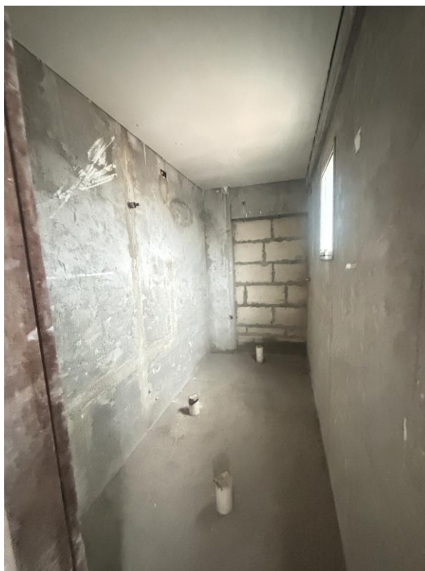
Figura 13: Banheiro da suíte 2.
