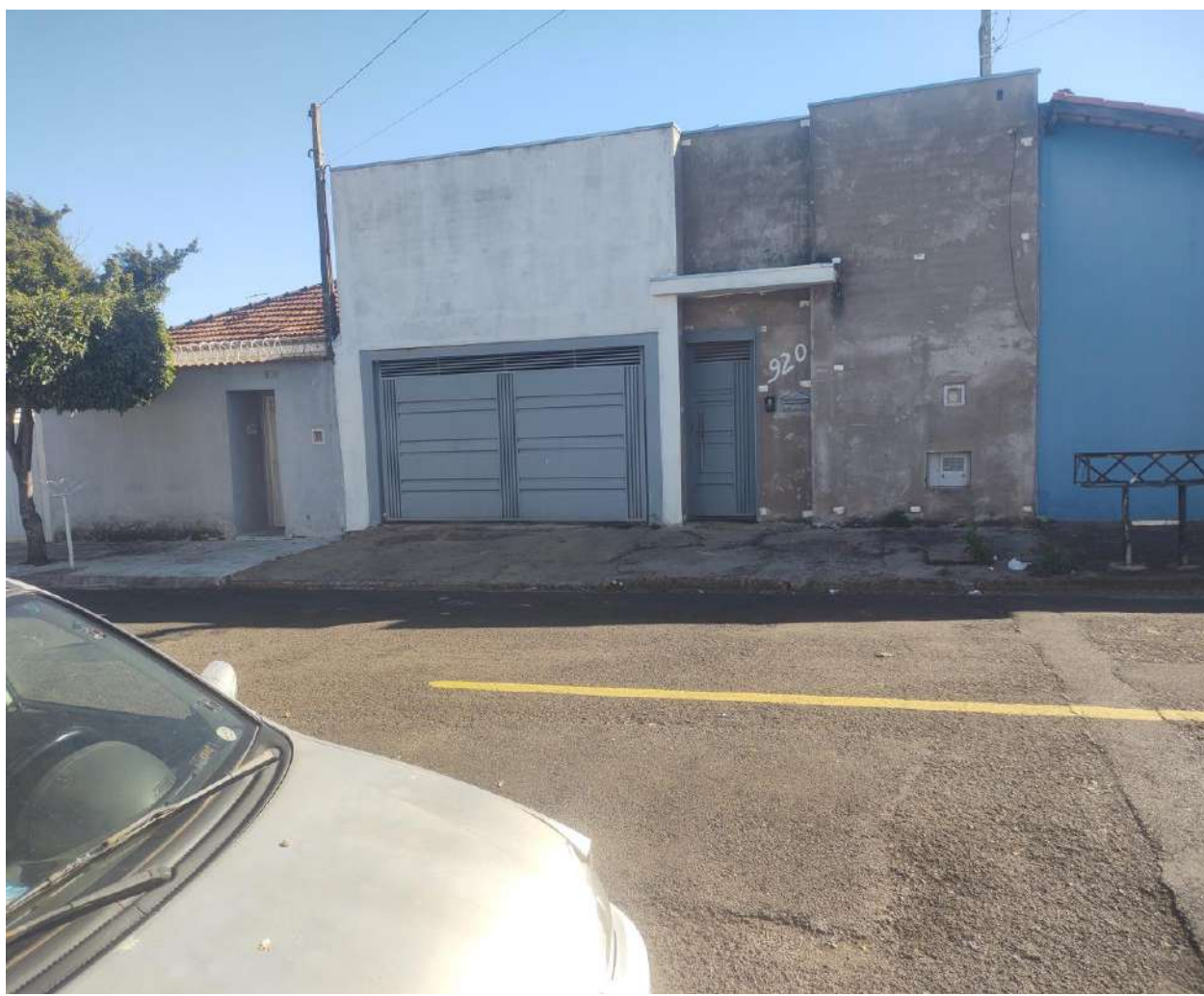
Vista frontal do imóvel
