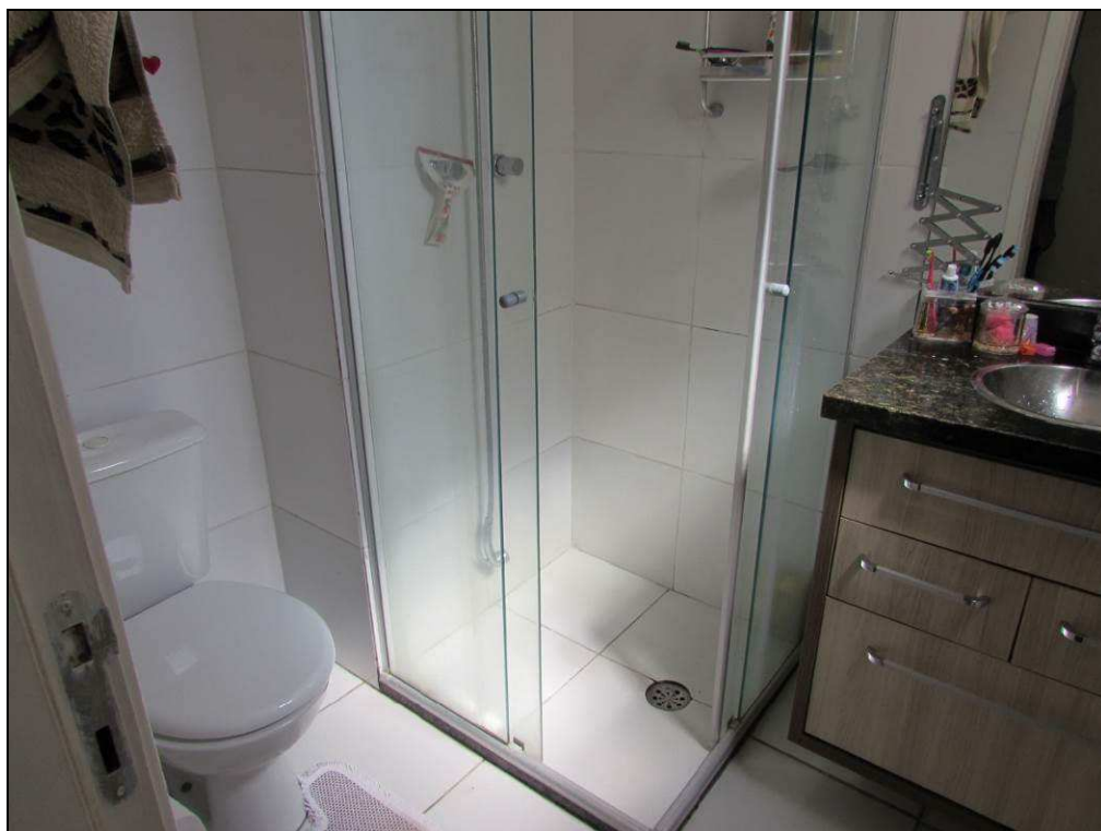
Foto 23: Vista do Banheiro pertencente ao Apartamento nº 17.
