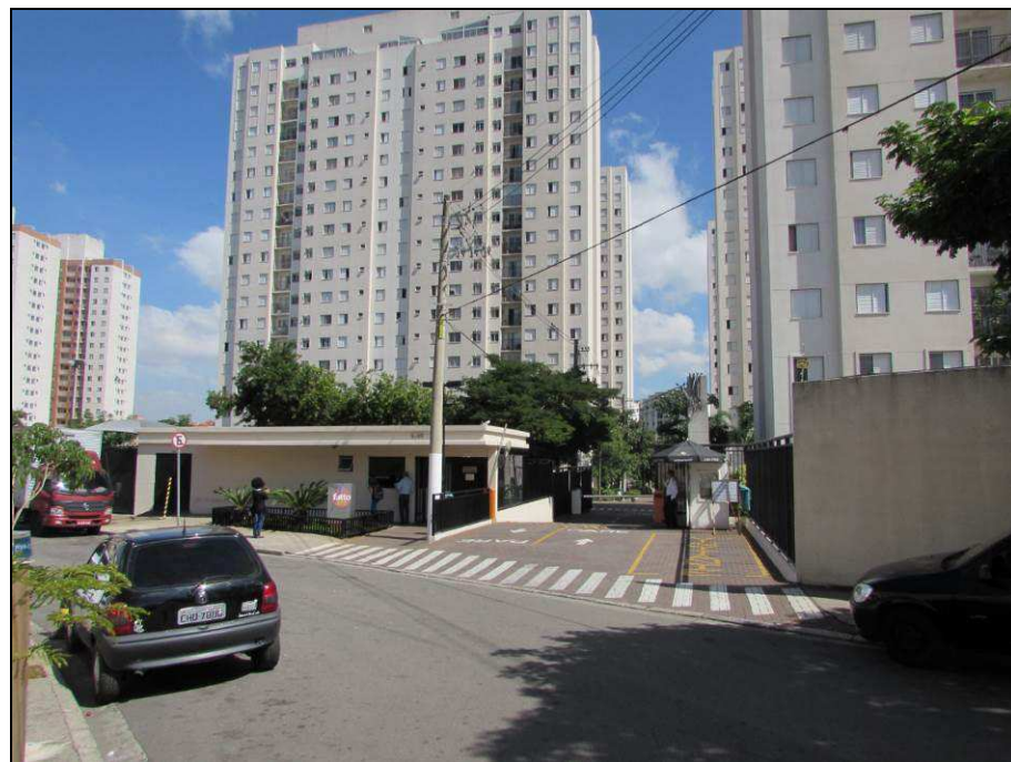
Foto 05: Vista da entrada do Condomínio Residencial Fatto Sport, localizado na Avenida Brigadeiro Faria Lima, nº 1.451 – Cocaia – Guarulhos – SP.
