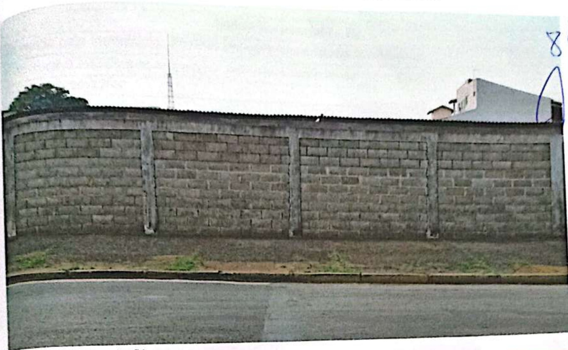
Foto 01 – Fachada esquina IA
