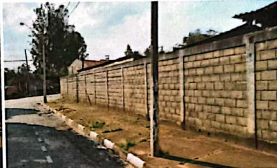
Foto 03 - Vista Logradouro lado esquerdo IA.
