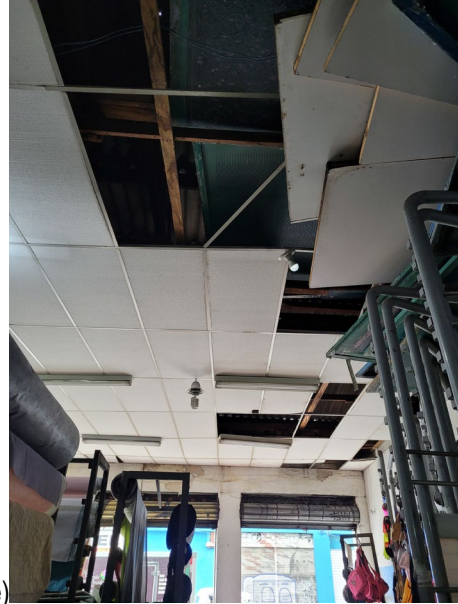
Vista parcial interior do imóvel (dos fundos para a frente)
