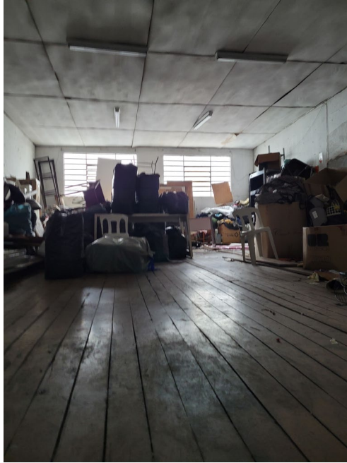
Vista parcial mezanino (piso em tábuas de madeira)
