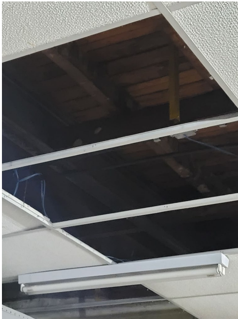
Detalhe teto rebaixado da loja (sob o mezanino)
