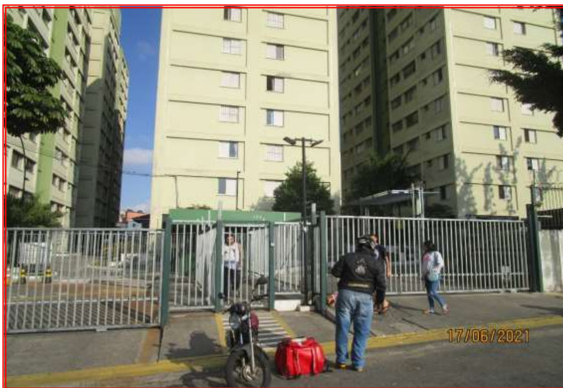
Foto nº 02: Vista geral da portaria central de moradores/visitantes e portões automáticos laterais de entrada e saída de veículos.
