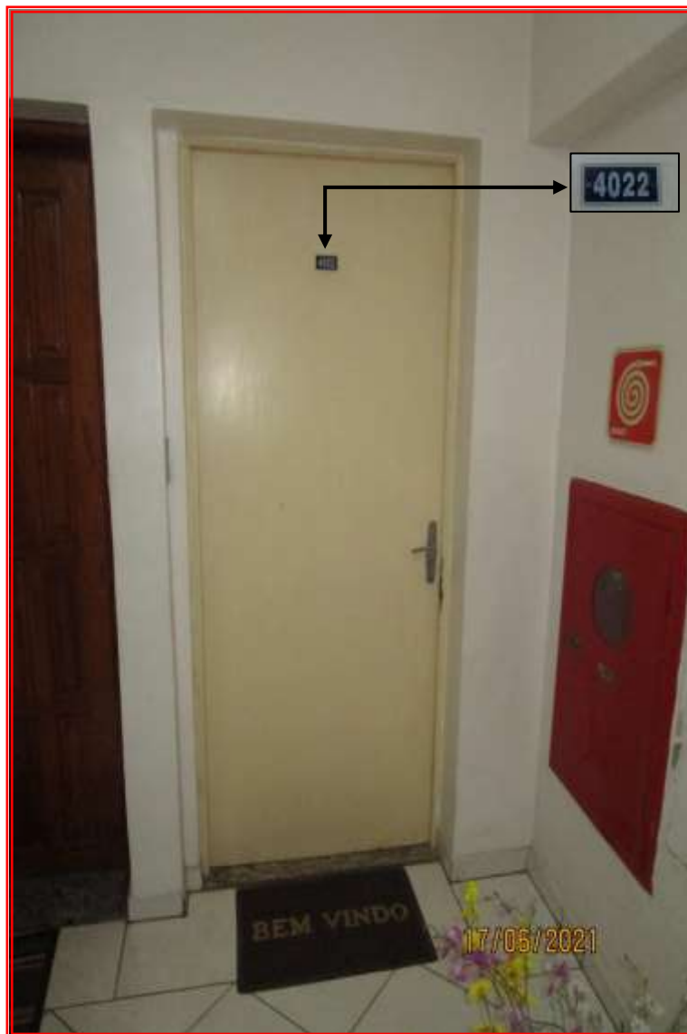
Foto nº 15: Vista parcial da porta de acesso ao interior do apartamento 4022. Na data da vistoria encontrava-se fechado.
