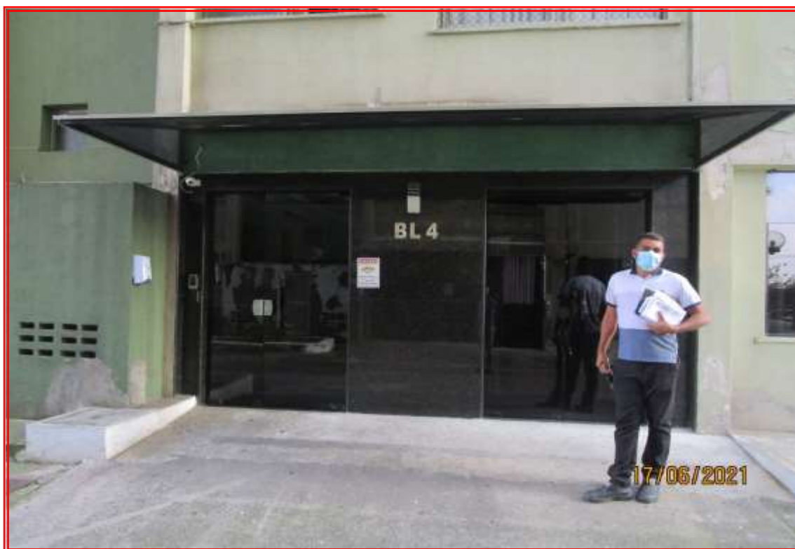
Foto nº 10: Vista geral da entrada do Bloco 4.
