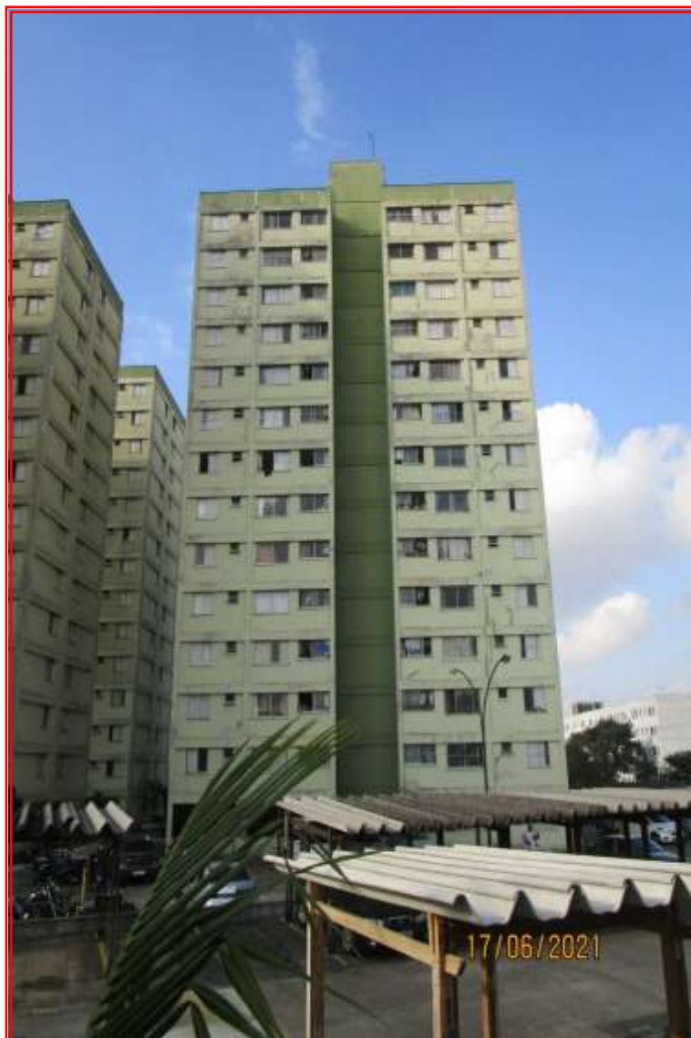
Foto nº 07: Vista geral da fachada do Bloco 4, onde se localiza o imóvel avaliando (4022 do 2º andar).
