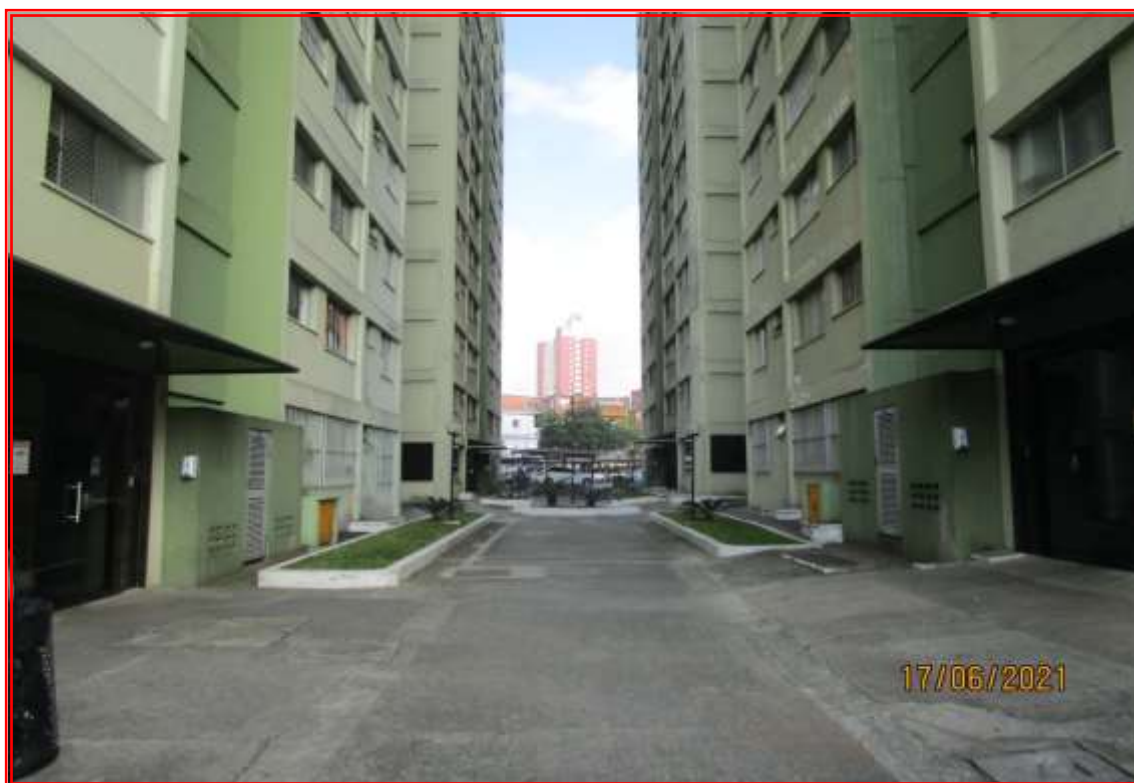
Foto nº 09: Vista parcial da alameda central de acesso aos blocos de apartamentos.
