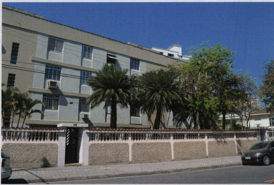
FOTO 01 :- Vista geral do imóvel.
