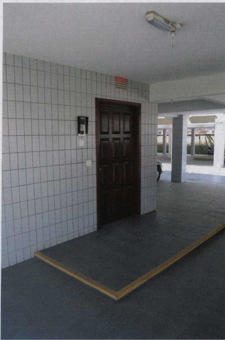
FOTO 03: vista para a porta de acesso a unidade.
