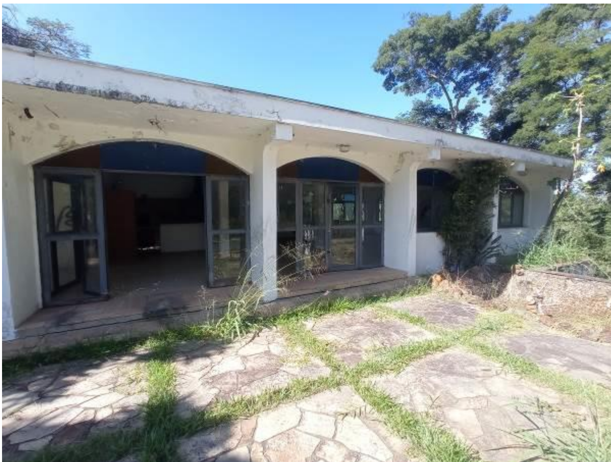
Foto 7: Vista do salão de festas abandonado
