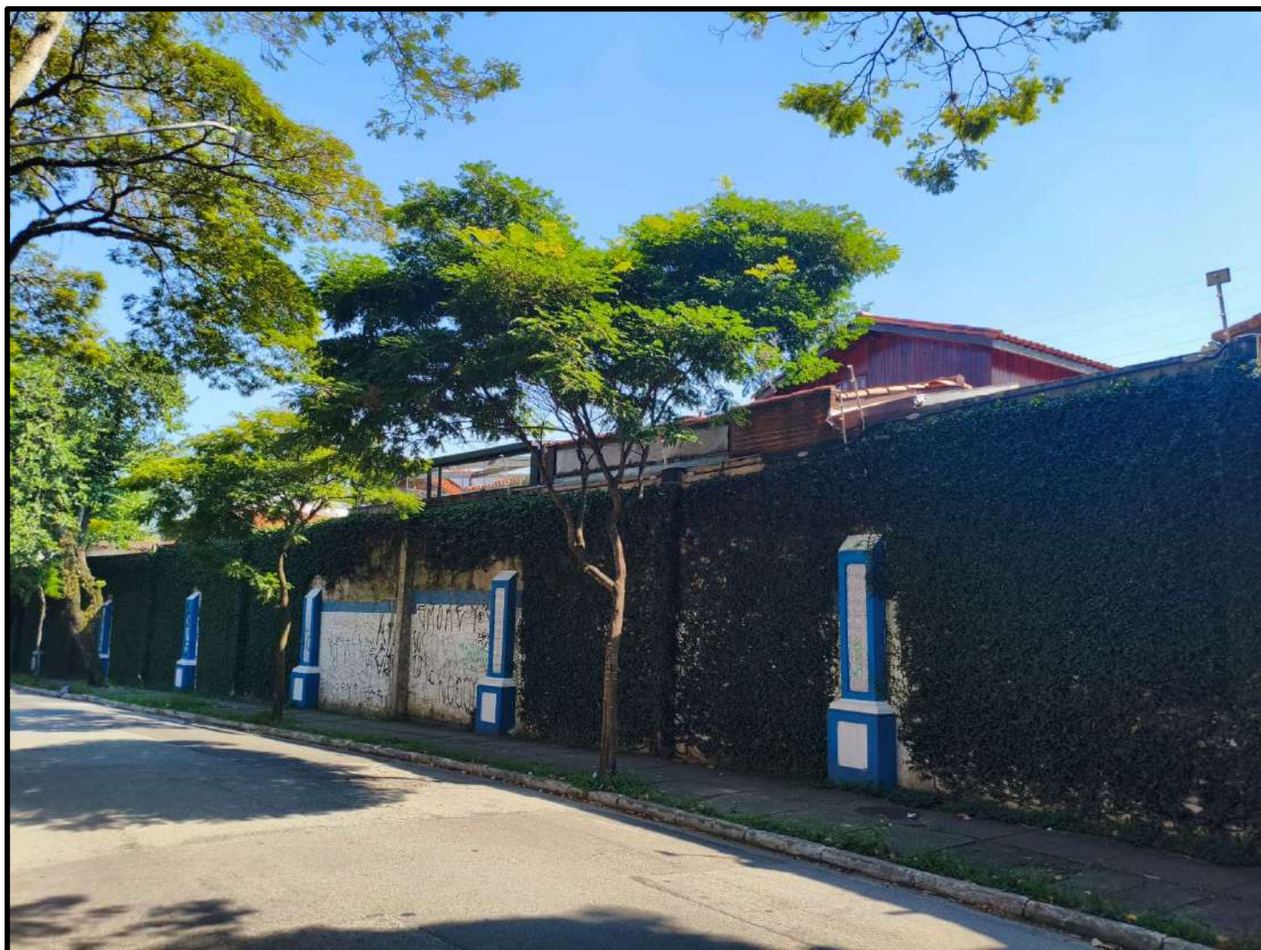
Imóvel do Condomínio Vila Nova Sintra.
