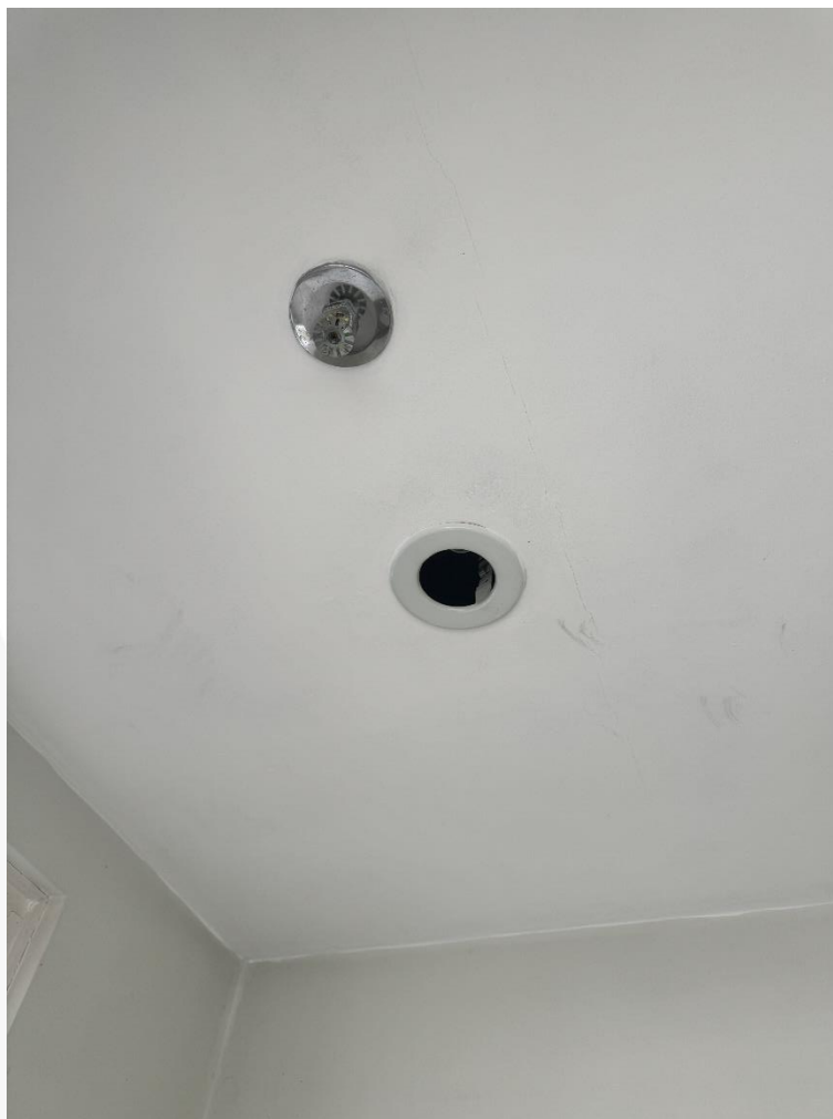
Foto 14: Detalhes da laje
