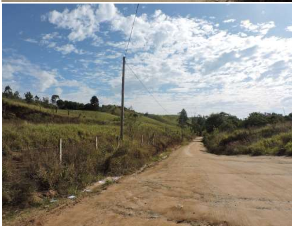
Vista da Estrada do Banho Turco (Do lado esquerdo e do lado direito da foto imóvel avaliado) (Destaca-se a Estrada secciona o imóvel em duas porções)
