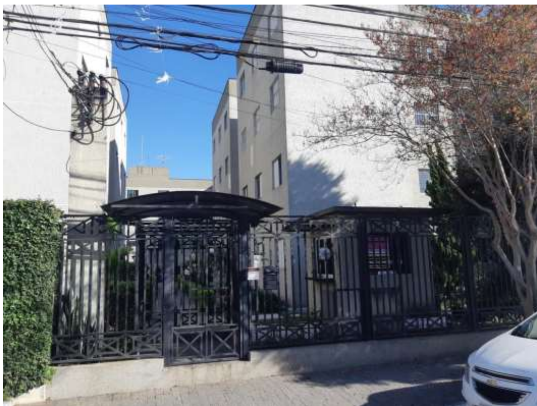
Figura 7: Fachada do Condomínio.
