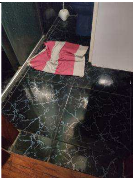
Foto 27 – Box e detalhe de piso cerâmico.
