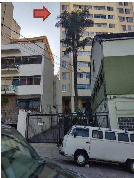
Foto 03 – Vista da fachada principal do Ed. Roma, localizado à Rua Paim, 90 – Bela Vista/SP.
