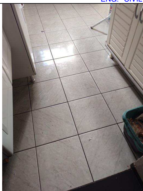
Foto 29 –Detalhe dos pisos da cozinha e lavanderia.
