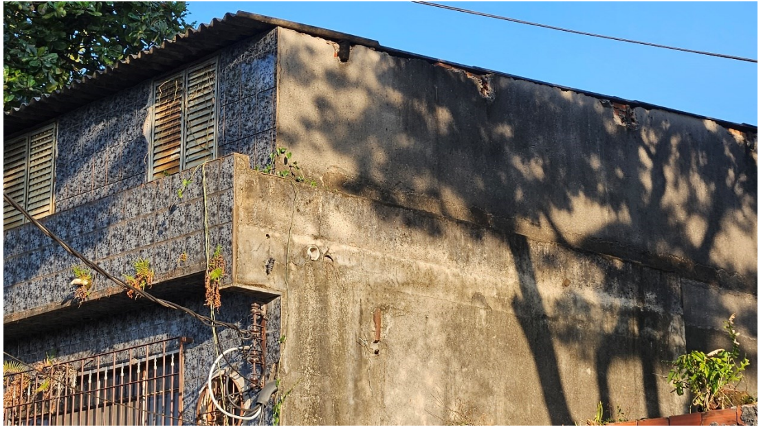
PAREDE LATERAL DIREITA EXTERNA FRENTE
