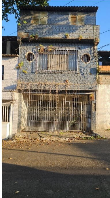
FACHADA DO PRÉDIO
