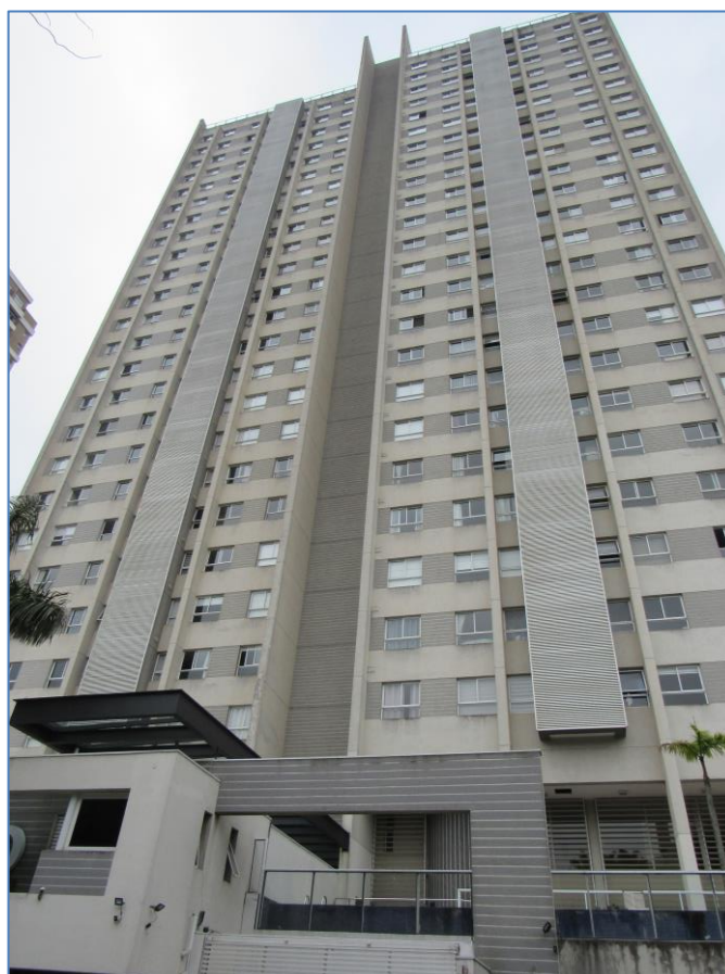
FACHADA DO IMÓVEL AVALIANDO (2).
