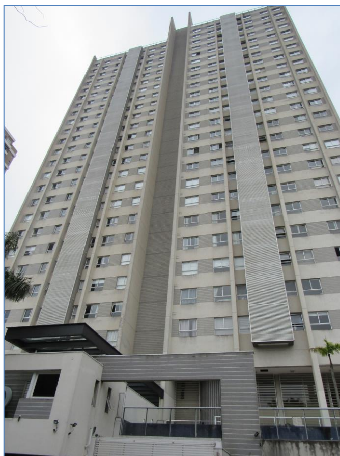
FACHADA DO IMÓVEL AVALIANDO (1).
