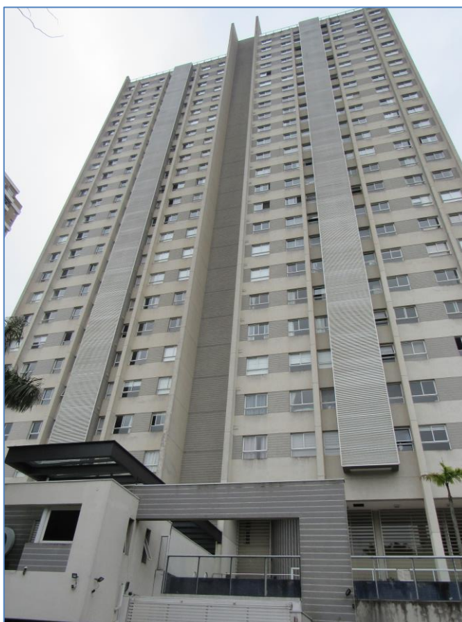
FACHADA DO IMÓVEL AVALIANDO (3).
