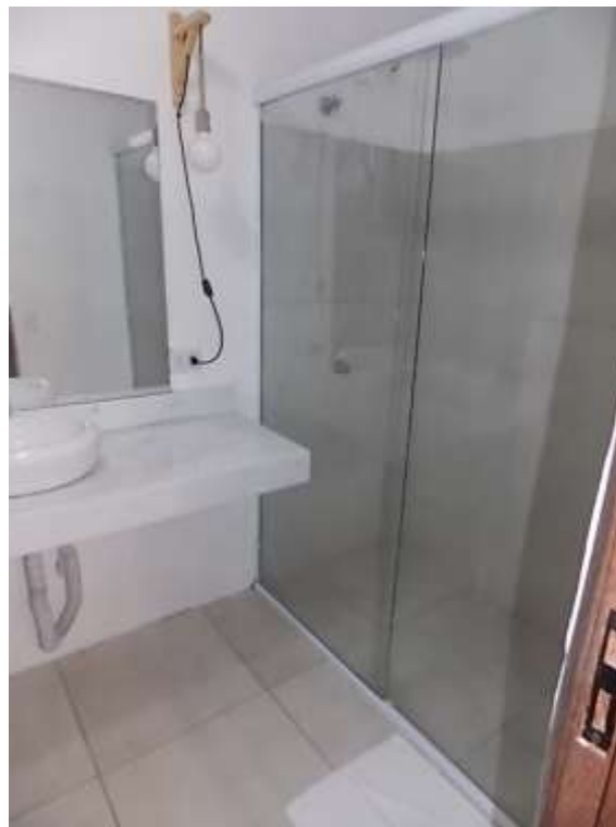
Foto nº 14 – Banheiro do chalé da foto anterior.
