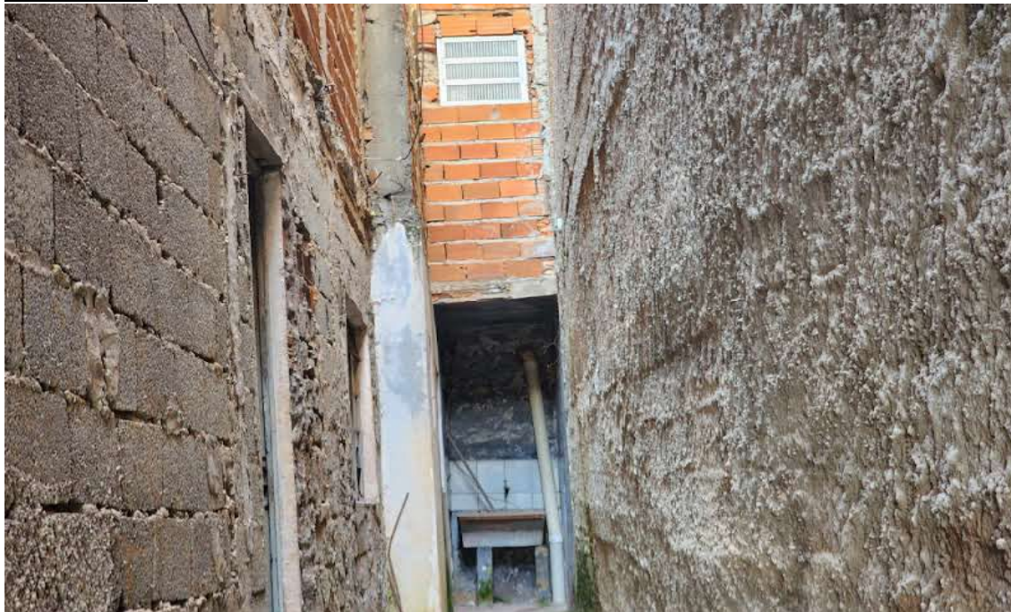
VISTA INTERNA DO IMÓVEL.
