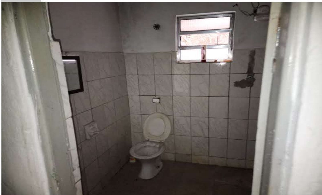
VISTA INTERNA DO IMÓVEL.
