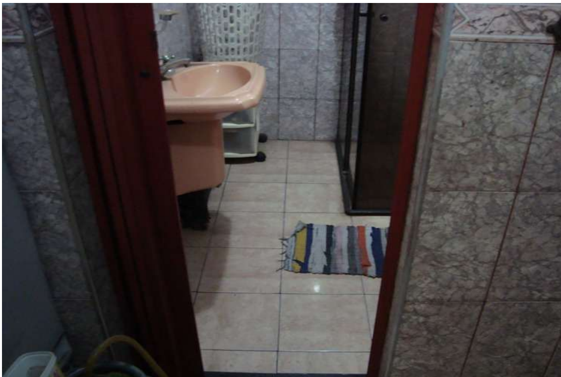
FOTO nº 60 Vista do w.c da Casa nº 02.
