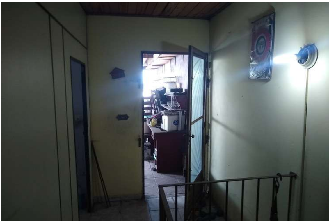
FOTO nº 68 Vista do acesso a cobertura da Casa nº 02.
