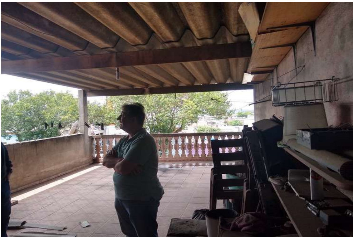
FOTO nº 70 Vista da cobertura na Casa nº 02.
