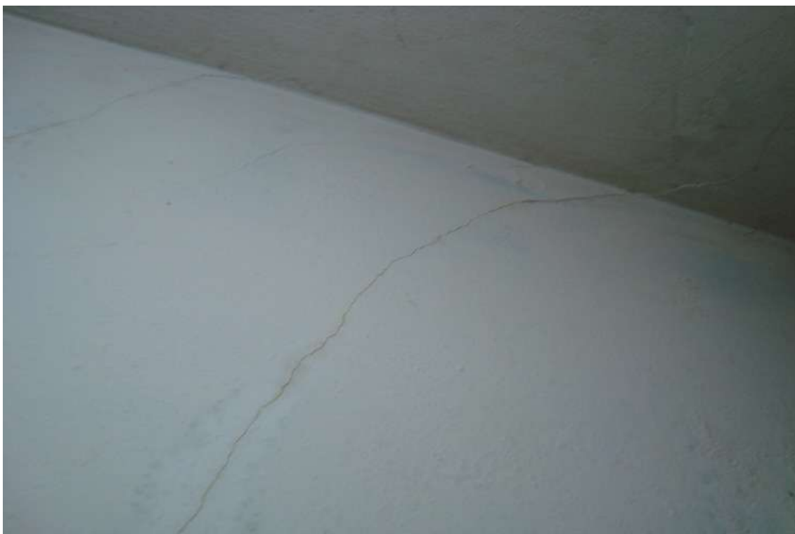
FOTO nº 28 Vista das fissuras e dos descasamentos em parede do corredor que dá acesso aos dormitórios na Casa nº 01.
