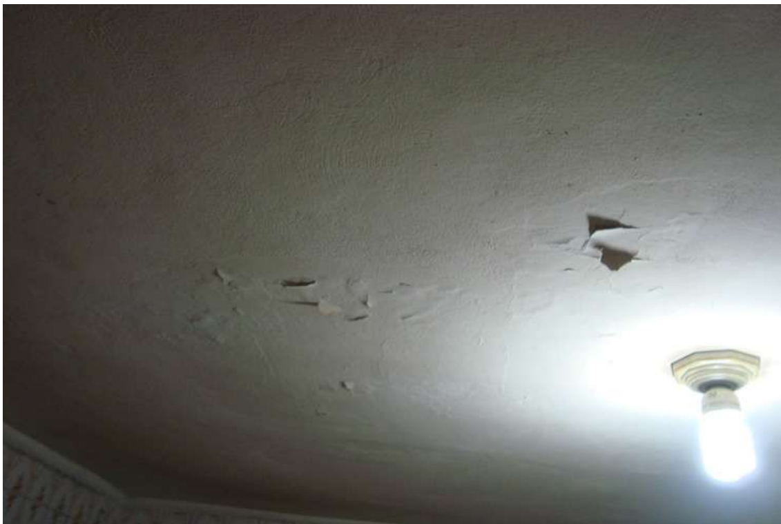
FOTO nº 38 Vista dos descasques no teto da cozinha pertencente a Casa nº 01.
