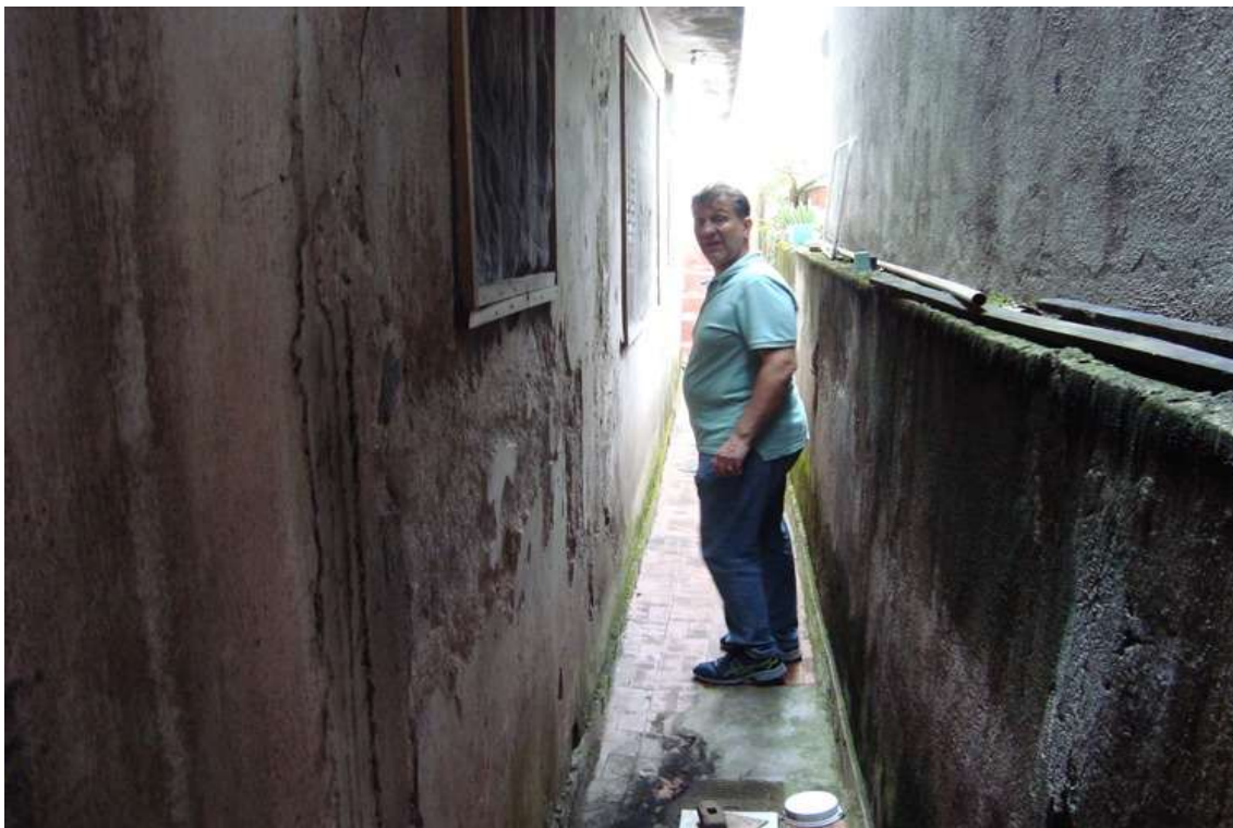
FOTO nº 43 Vista do recuo lateral da Casa nº 01.
